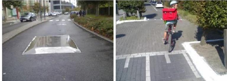
Figure 109 : Exemples de ralentisseurs adaptés aux cyclistes
