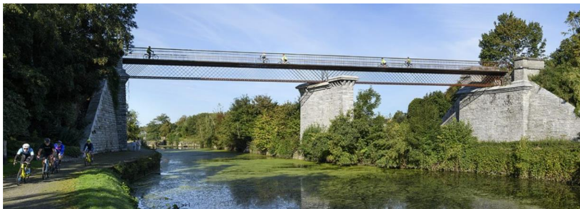
Passerelle RAVeL L141 Arquennes ~ 920 000 € avec rénovation des piles 2023
