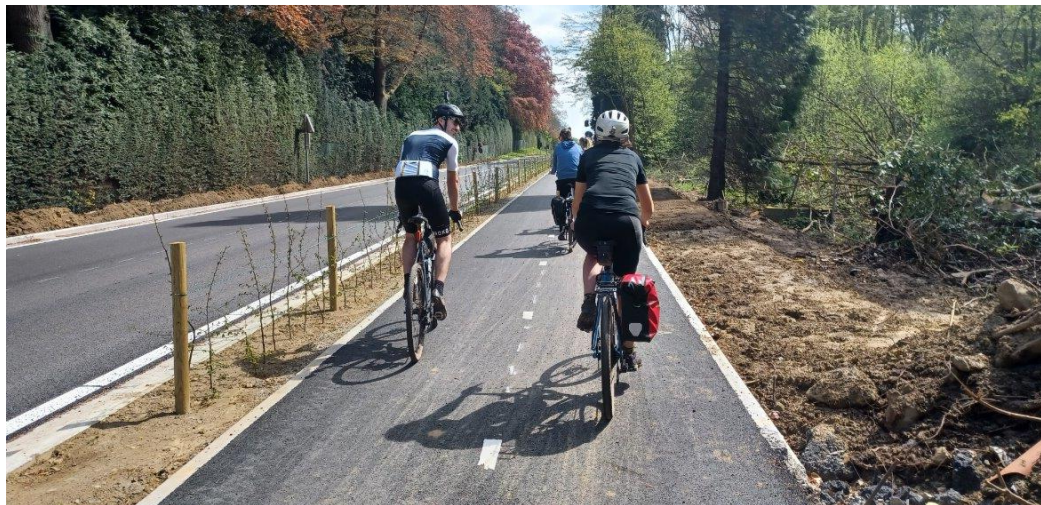
Cyclostrade N275 (y compris réfection chaussée) 1,850 km – 2,493 millions€ = 1,348 million€/km - 2023
